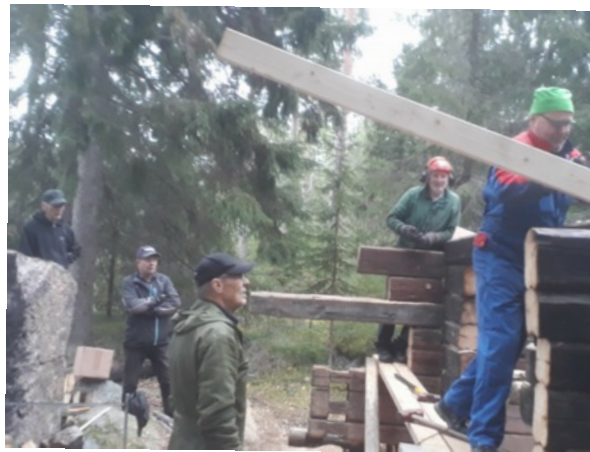
Laavun rakentajat työssä
