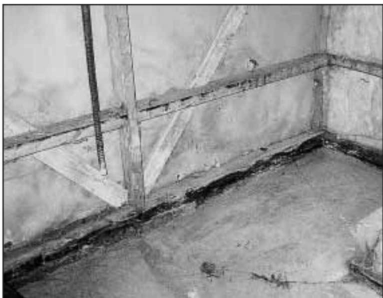
Sauna remontin alussa, rakenteet purettuina.
